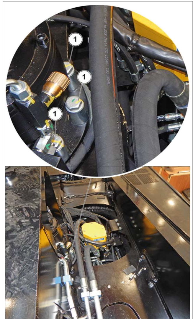
Figure 166: Vérification du serrage de la vis de fixation du réducteur de rotation
